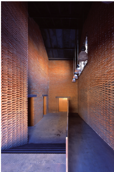
Parois séparatrices avec d'anciennes tuiles Abattoir 8B / Matadero, Madrid / Arturo Franco / 2009
